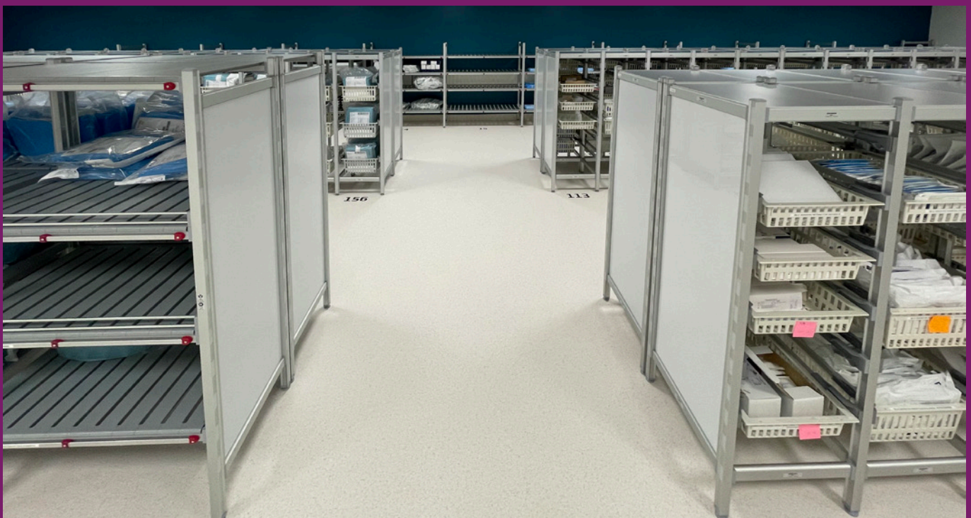
Close up efter installation
