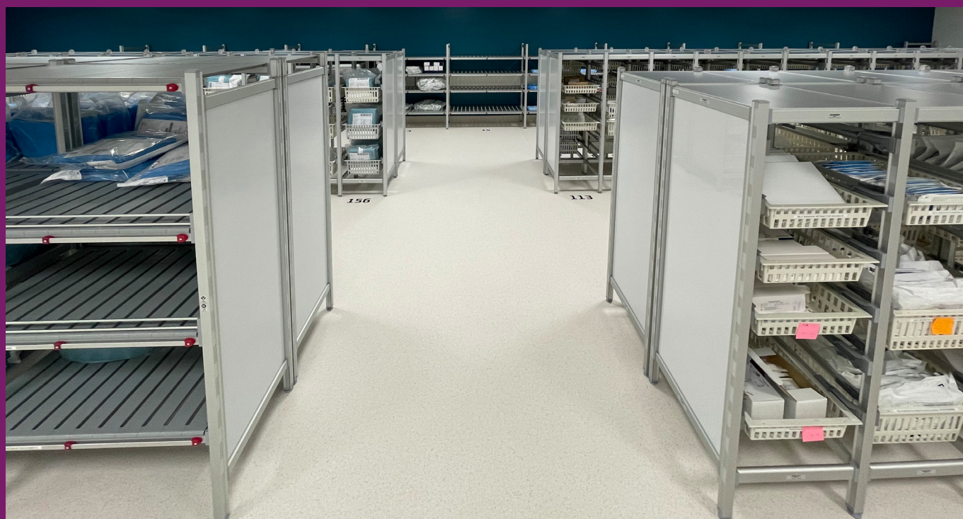
Close up efter installation
